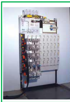
Nowa instalacja z zabezpieczoną przed dotykiem szyną zbiorczą
